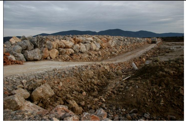
Fig. 24 - Costruzione dell'argine a mare
