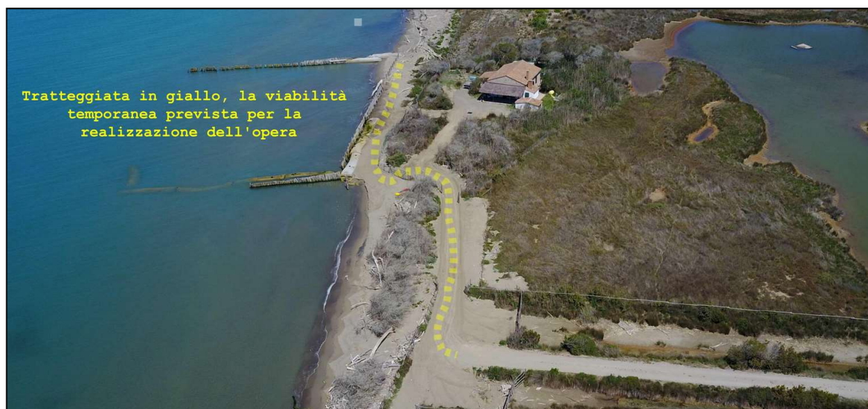
Figura 30 percorso della pista per il trasporto dei materiali e dei mezzi operativi
