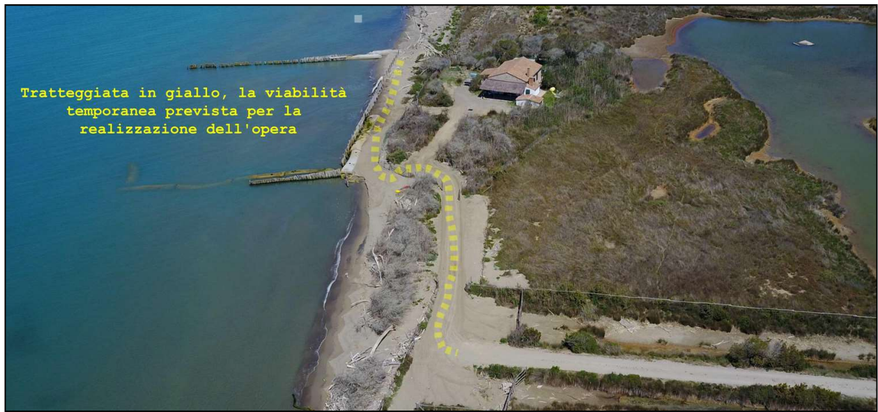
Figura 30 percorso della pista per il trasporto dei materiali e dei mezzi operativi
