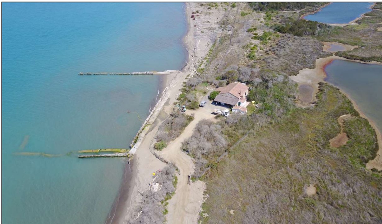
Figura 25 situazione della spiaggia antistante la Casetta il 13/06/2017
