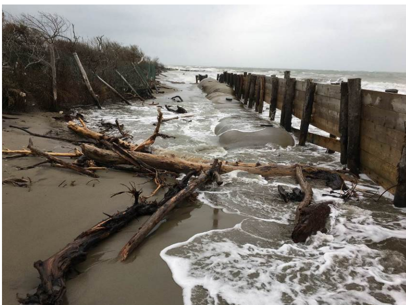
Foto 6 Vista della area di intervento durante una mareggiata, in evidenza gli interventi con palificate autorizzati con determina dirigenziale . n. 2043 del 06/11/2015.
