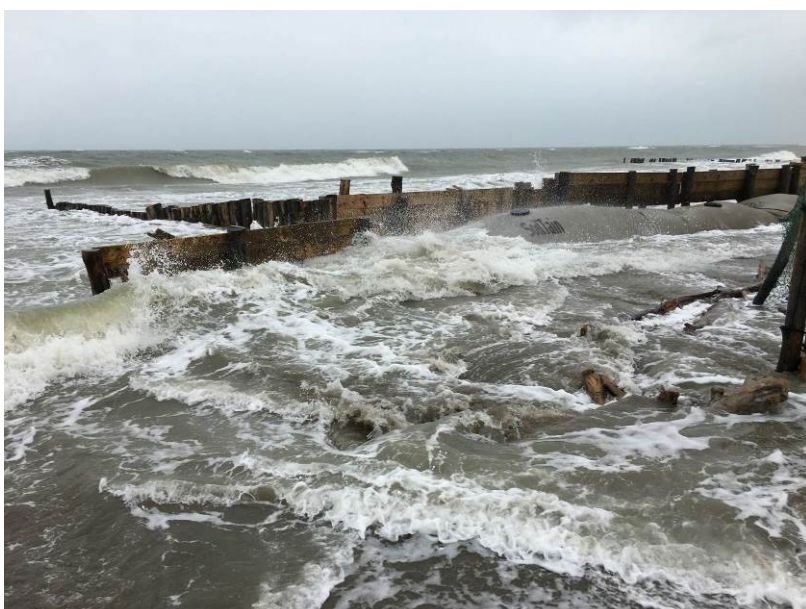
Foto 3 Vista della area di intervento durante una mareggiata, in evidenza gli interventi con palificate autorizzati con determina dirigenziale . n. 2043 del 06/11/2015
