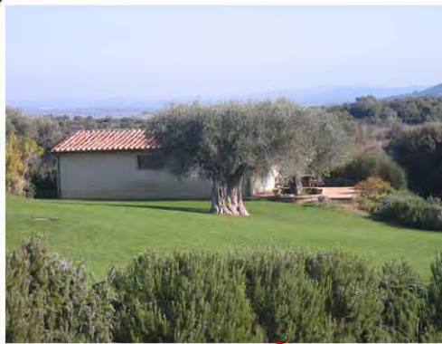
7: Annessi agricoli, magazzino
